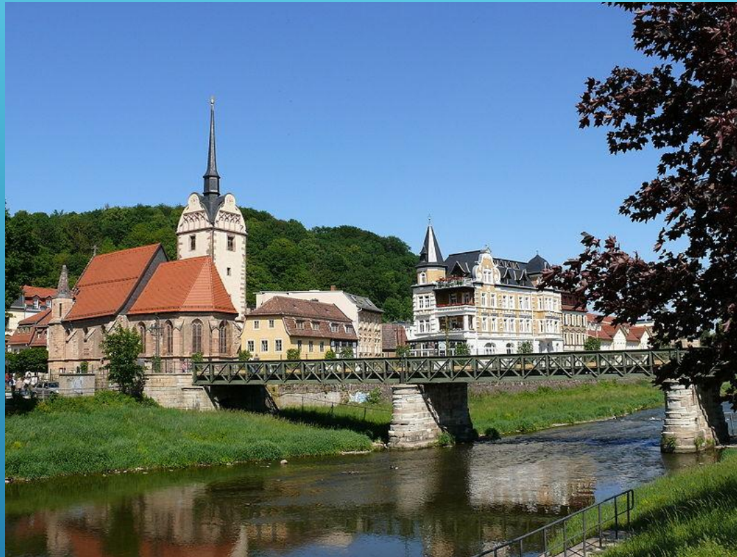
Überflutungsfläche an der Unterhäuser Brücke.
