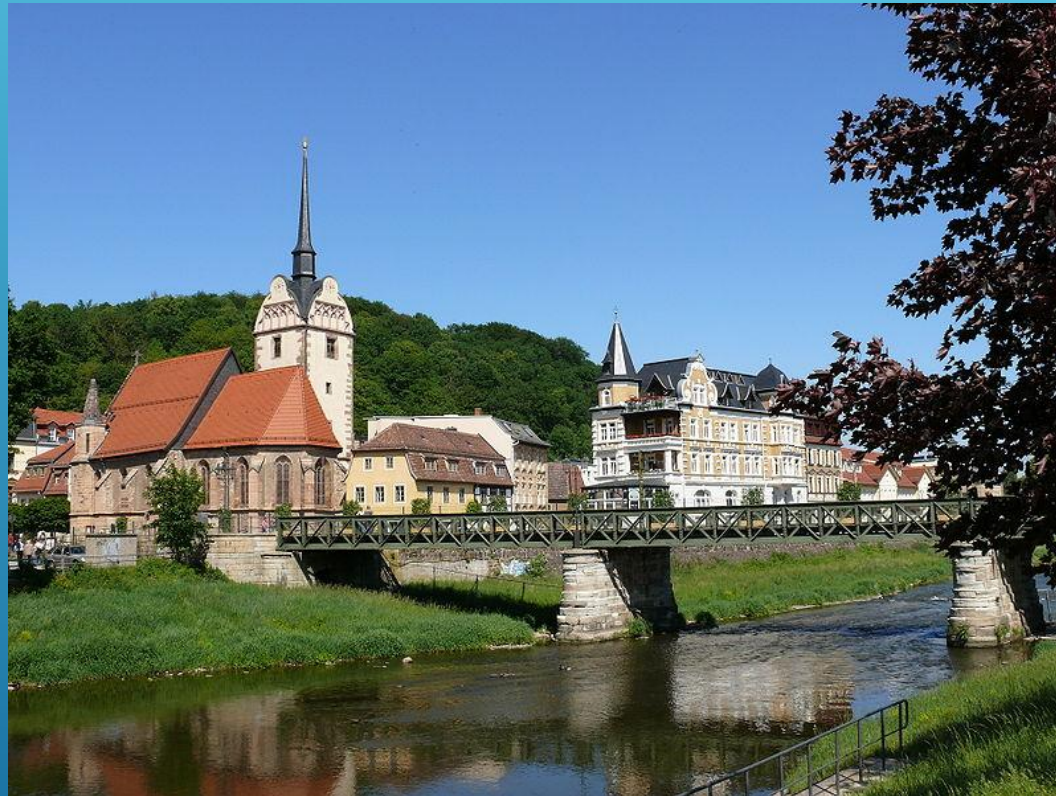
Überflutungsfläche an der Untermhäuser Brücke. Foto: J. Mustermann
